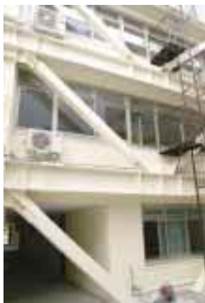
耐震ブレースで補強
