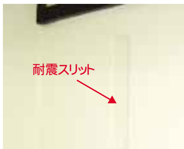
側壁の各所には「耐震スリット」を入れました
