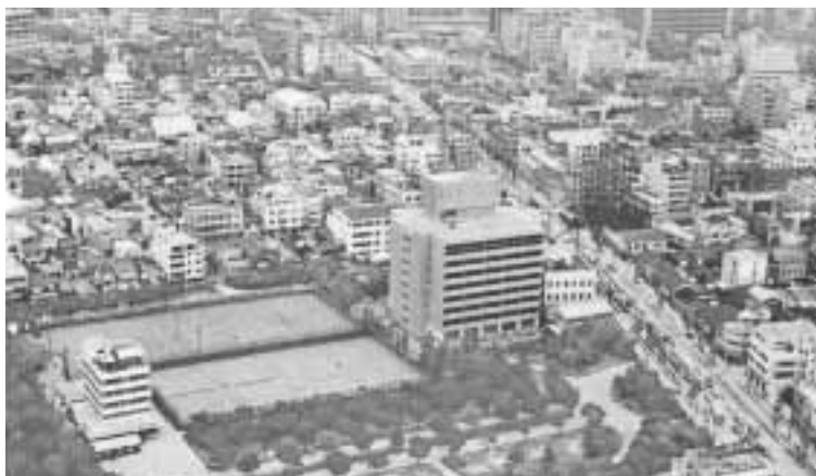
昭和38年竣工当時の大阪科学技術センタービル
