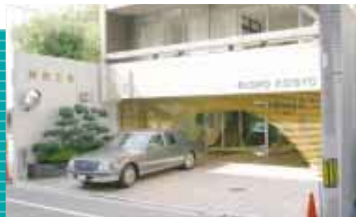
玄関には耐震ブレースが入りました。
