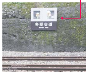
▲冬期歩道(外観)
