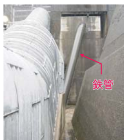
▲新設された水圧鉄管
