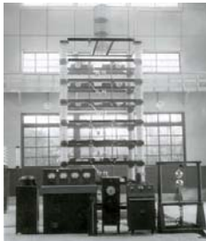
▲105万ボルト 衝撃電圧発生装置 (1953年/尼崎工場)
