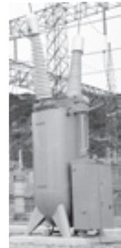
270キロボルトコンデンサ形ブッシングを使用したしゃ断器
