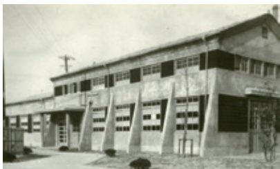
▲高圧実験室(尼崎工場)
