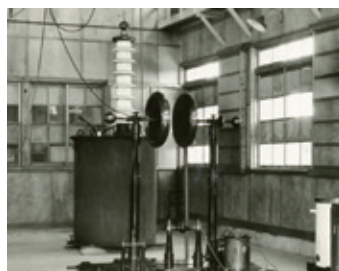
▲12万ボルト試験用変圧器(1929年)
