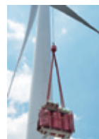
▲ナセルに搭載される リショーキャスト変圧器
