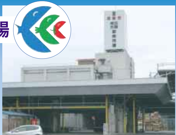
▲尼崎市公設地方卸売市場
