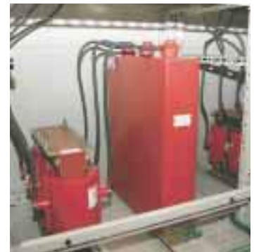
▲リショーモールド高圧進相コンデンサ『モルコン』。直列リアクトルと組み合わせてご使用下さい。
