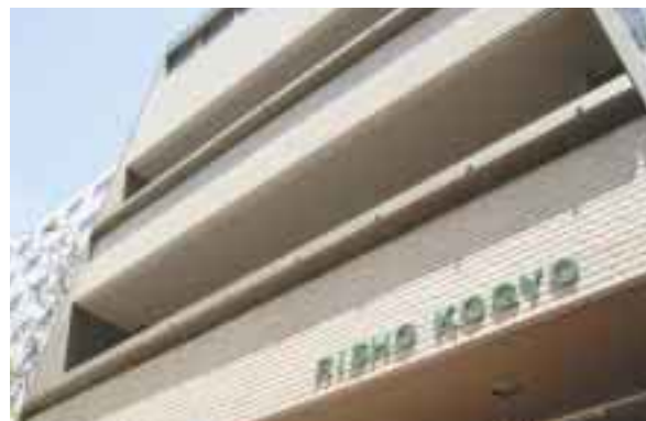
▲利昌工業 本社ビル 10月末まで耐震補強工事を行います
