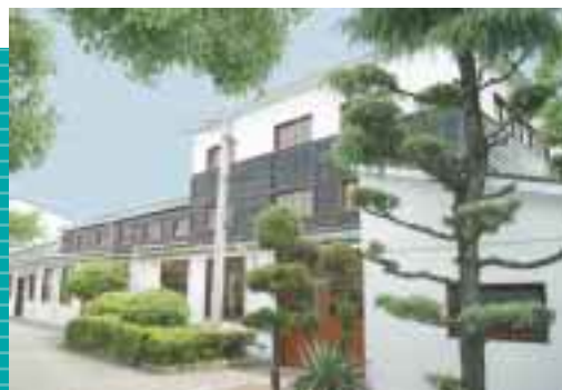
▲改修された高圧実験室
