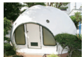
▲フローラ(2024年)。50年の風雪を経て、錆も腐りもなしです。
