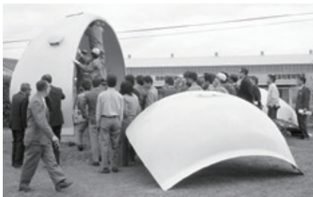
▲クレーンを用いることなく4人の作業員で1日足らずの工期で完成。
