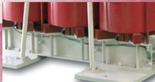
▲混触防止板から引き出されたB種接地線(みどり色のコード)
