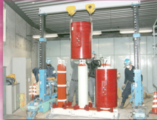
▲部品で搬入 → 現地で組み立て
