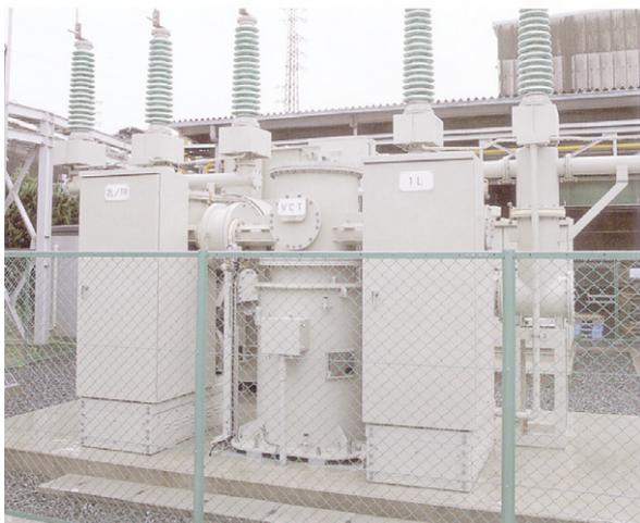
72/84kV受変電用超小型ガス絶縁開閉装置
