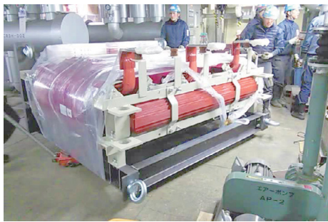
▲図3 脱着式フレームを装着しての横倒し搬入のようす 下記のサイトで動画をご覧くださいませす
