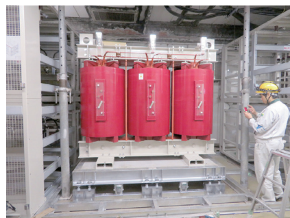
▲L字フレームを外して、据え付け完了
