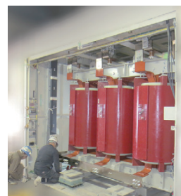
▲更新にあたり3000kVAの変圧器(既設品)があったスペースに納まった4000kVAのリショーキャスト変圧器
