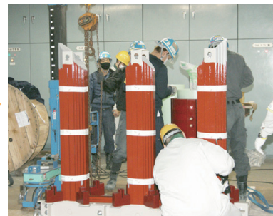
▲上部の鉄心を取り外した状態。このあとそれぞれの鉄心にコイルをセットします。
