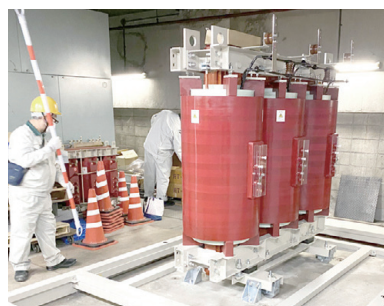
▲所定の場所にセットされた変圧器
