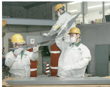
▲コイルをセットするため、いったん上部の鉄心(薄い鋼板)を外します。
