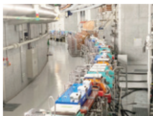
▲蓄積リング。電子は周長約350mのこのリングを1秒間に86万回も周回します。手前の青いパーツは偏向電磁石。
